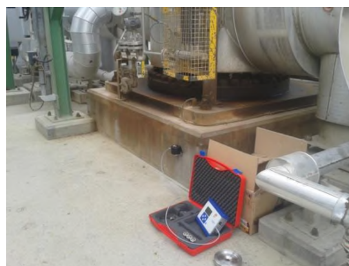
Установка датчика в позицию 1
