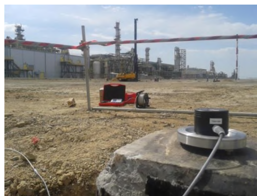
Установка датчика в позицию 3
